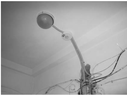
(Рисунок 6 – Датчик движения на лестничной площадке)
